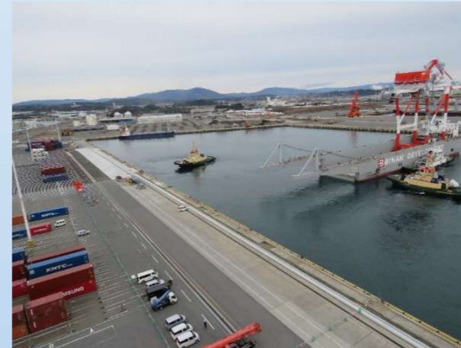
《新設クレーン据付状況（R6.1.3）》
